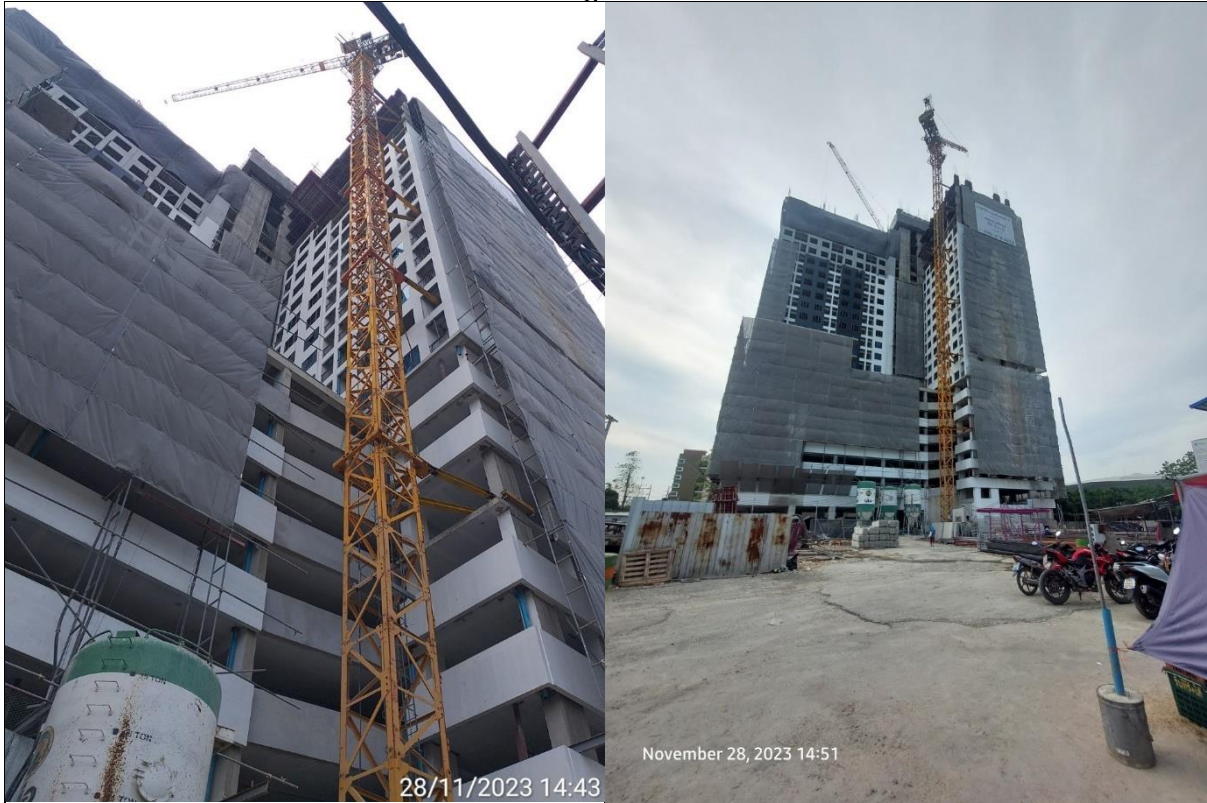
รูปที่ 2-34 ปั่นจั่นแบบทอสูง (Tower Crane)
